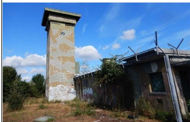
Dieser Wachturm ist nicht wie die beiden anderen Türme als Metallkonstruktion ausgeführt, sondern in massiver Beton-Bauweise.
