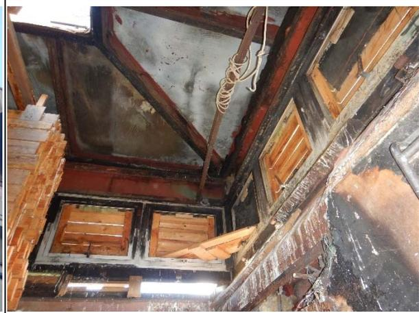
Innenansicht der Turmkanzel. Der Turm wurde im Sinne eines sog. „Bat-Condo“ ausgestattet.
