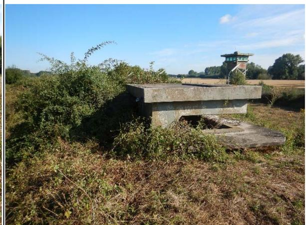
Die Geschützstellungen sind ebenerdig gebaut, jedoch umgibt der künstlich errichtete Wall sie von drei Seiten. Mehrere dieser Bauwerke sind von Brombeeren vollständig überwachsen und können nicht mehr begangen werden.
