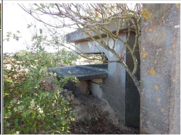
Der Raketen-Abschussplattform abgewandte Rückseite der Geschützstellungen mit Eingangsöffnung. Die hier dargestellte Geschützstellung ist wenig bewachsen. Bei den meisten ist der Eingang völlig durch Sträucher zugewachsen und nicht mehr passierbar.
