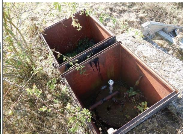
Die Tanks sind vollständig in den Boden eingelassen. Der Deckel schließt mit der Erdoberfläche, darum herum sind quadratische Schachtbauwerke angebracht. Versteckmöglichkeiten für Tiere befinden sich hier nicht.
