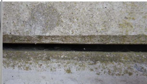
Die sehr schmalen vorhandenen Spalten, an denen die einzelnen Beton-Fertigteile aufeinanderliegen, wurden bei jeder Geschützstellung untersucht. Mit bis zu 1,5 cm Spaltenbreite könnte hier eine Zwergfledermaus ggf. hineinpassen. Jedoch beträgt auch die Spaltentiefe überall nicht mehr als 2 cm. Damit scheidet eine Nutzung für Quartiere wiederum aus.
