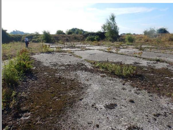
Die großflächigen Betonplatten der Abschussplattformen sind noch vorhanden. Sie sind stellenweise bereits etwas übererdet oder mit Moos bedeckt, in den Fugen wächst typische Pioniervegetation auf.
