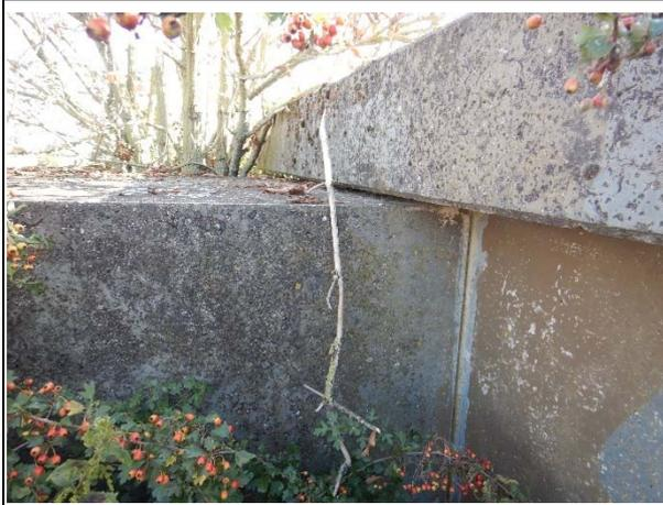
Die Geschützstellungen sind aus massiven Betonteilen gefertigt, die fest miteinander verbunden sind.
