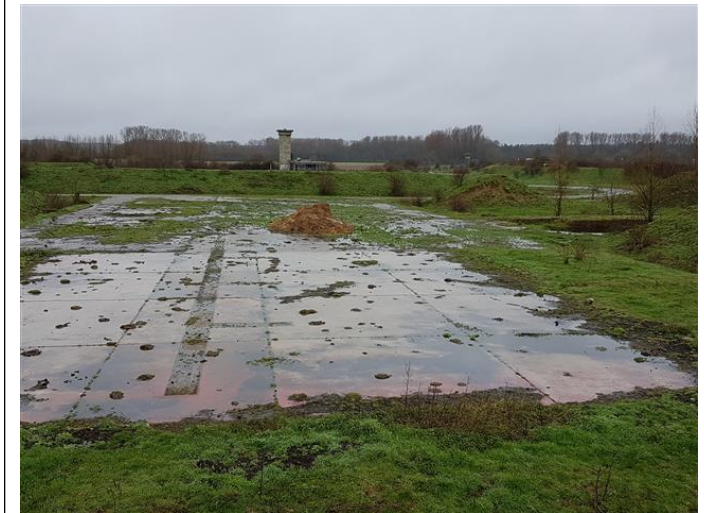
Abbildung 3: Betonfläche 3 (Blickrichtung NW)
