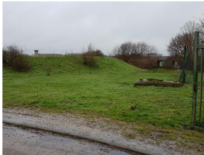
Abbildung 2: südöstlicher Wall der Betonfläche 3 (Blickrichtung N)
