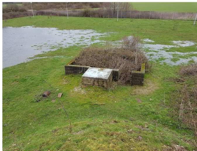
Abbildung 17: Altfundament nordöstlich Betonfläche 1 (Blickrichtung NO)
