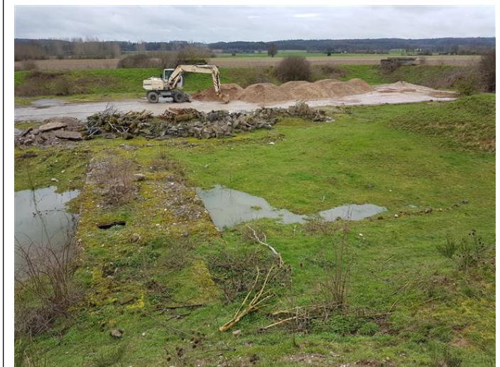
Abbildung 18: Betonfläche 1 (Blickrichtung SW)
