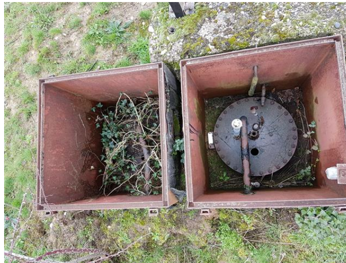
Abbildung 8: Domschacht; Tank bei Betonfläche 3 (Blickrichtung SW)
