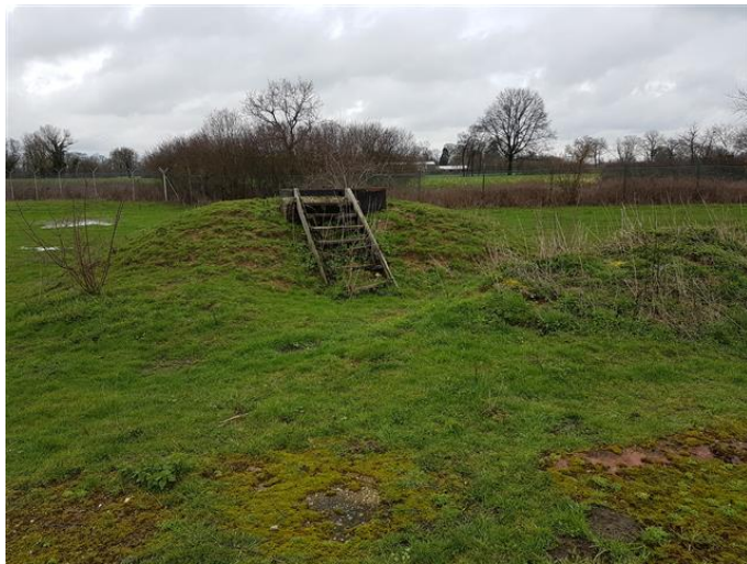
Abbildung 7: Tank bei Betonfläche 3 (Blickrichtung NO)
