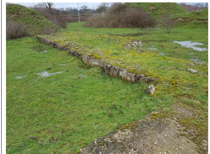
Abbildung 15: Altfundament bei Betonfläche 2 (Blickrichtung O)
