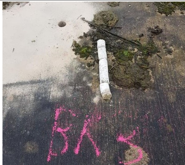
Abbildung 14: Betonkern Abschussplattform Betonfläche 2 (Blickrichtung NO)
