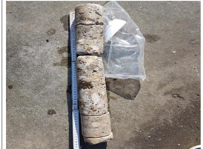
Abbildung 21: BK 3; Abschussplattform Betonfläche 2
