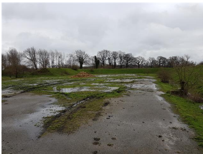
Abbildung 4: Betonfläche 3 (Blickrichtung SO)
