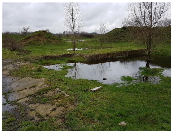
Abbildung 5: Altfundament bei Betonfläche 3 (Blickrichtung N)
