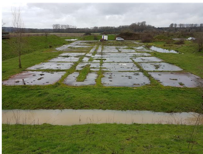
Abbildung 10: Betonfläche 2 (Blickrichtung NW)
